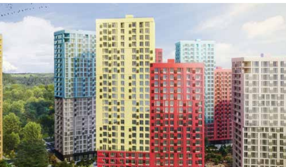
Рис. 1. Фото ЖК «Світло Парк», жилой дом № 3
